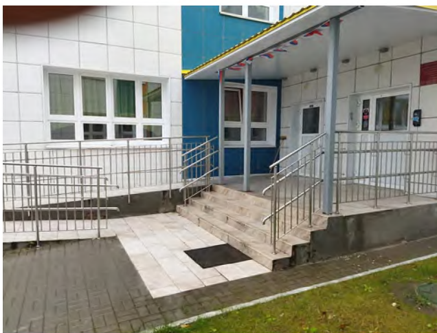
Пандусы на входе
